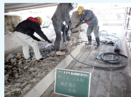
▲護岸撤去状況
