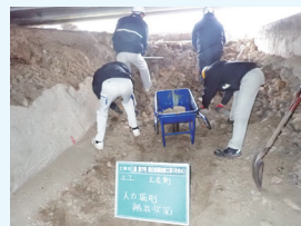
▲人力掘削状況
